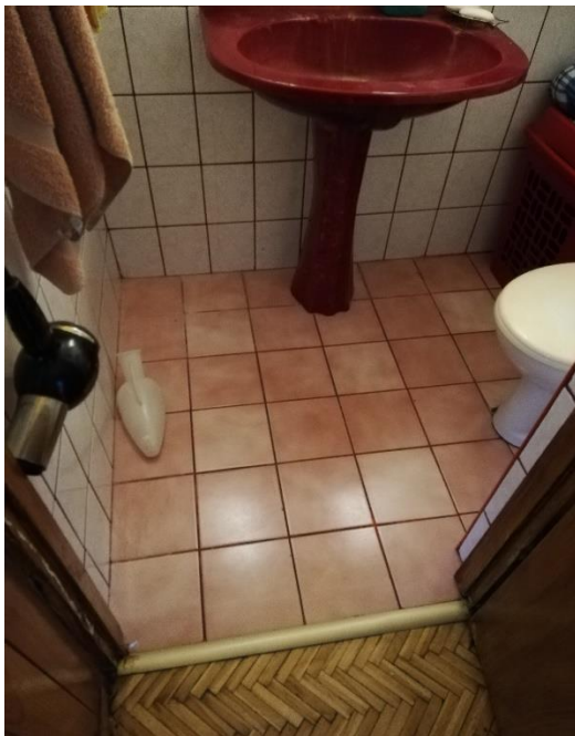
Pomieszczenie przed likwidacją
