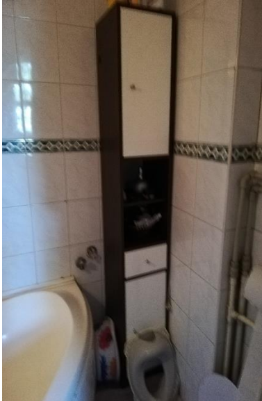
Pomieszczenie przed likwidacją
