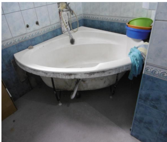
Pomieszczenie przed likwidacją barier architektonicznych
