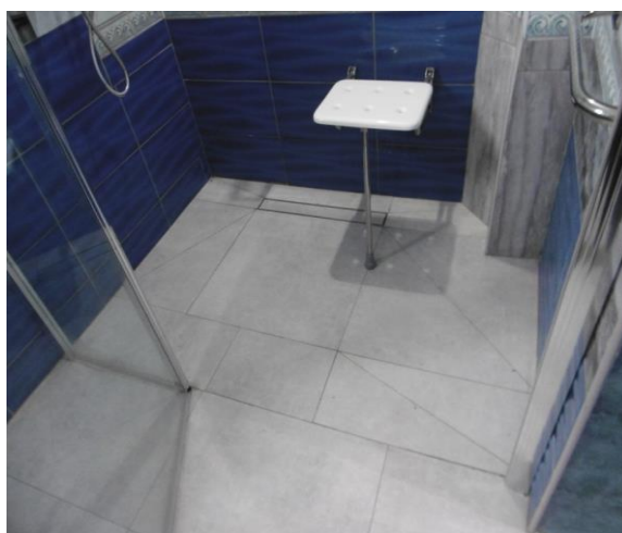
Pomieszczenie po likwidacji barier architektonicznych
